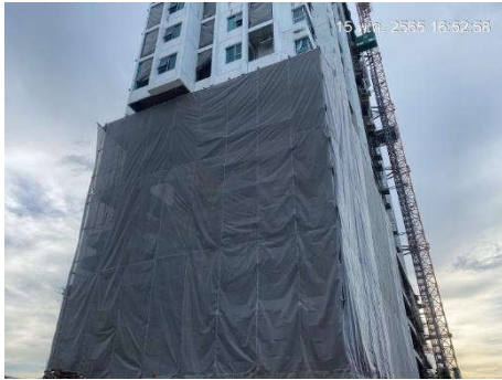
ภาพที่ 2.2-59 (ต่อ) การติดตั้ง Mesh Sheet และ Chain Link
