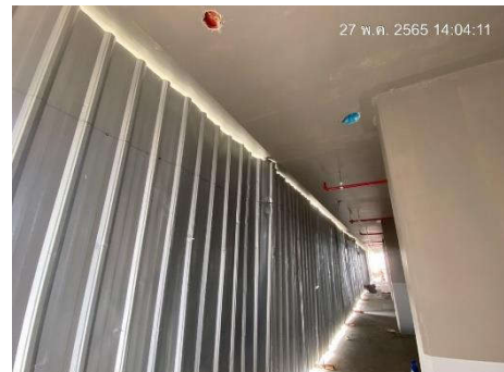
ภาพที่ 2.2-60 การติดตั้งแผ่นกันเสียงแบบเคลื่อนย้าย (Metal Sheet)
