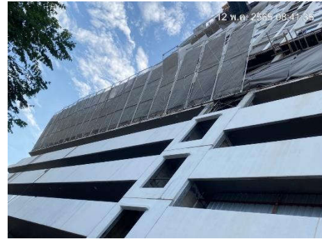
ภาพที่ 2.2-59 (ต่อ) การติดตั้ง Mesh Sheet และ Chain Link
