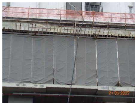
ภาพที่ 2.2-59 การติดตั้ง Mesh Sheet และ Chain Link
