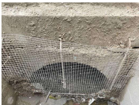
ภาพที่ 2.2-65 ตะแกรงดักขยะภายในบ่อพักน้ำ
