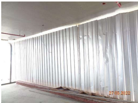
ภาพที่ 2.2-60 การติดตั้งแผ่นกันเสียงแบบเคลื่อนย้าย (Metal Sheet)
