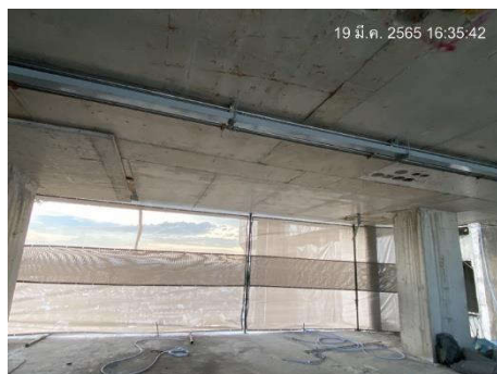
ภาพที่ 2.2-59 การติดตั้ง Mesh Sheet และ Chain Link
